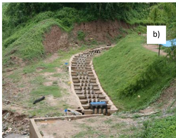
ຮູບທີ 8: ແຮ່ວັກປາ ທີ່ຕັ້ງໄວ້ຢູ່ຂັ້ນໄດປາ ຈຸດ a) ທາງເຂົ້າ ແລະ ຈຸດ b) ຢູ່ທາງອອກ
