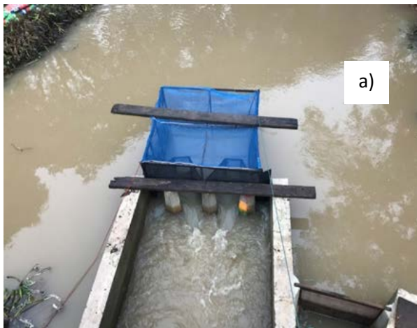
ຮູບທີ 8: ແຮ່ວັກປາ ທີ່ຕັ້ງໄວ້ຢູ່ຂັ້ນໄດປາ ຈຸດ a) ທາງເຂົ້າ ແລະ ຈຸດ b) ຢູ່ທາງອອກ
